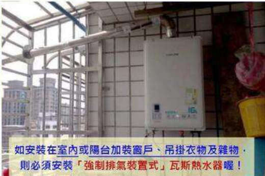
瓦斯熱水器安裝錯誤！排油煙管不是強制排氣管喔！
