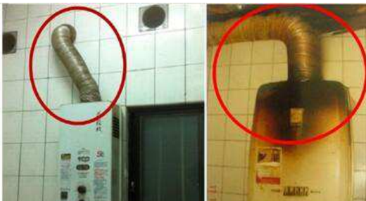
瓦斯熱水器安裝錯誤！排油煙管不是強制排氣管喔！
