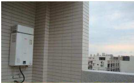
「自然排氣式」瓦斯熱水器必須安裝在通風良好處，陽台不可加裝窗戶、吊掛衣物或雜物，以免影響空氣對流！
